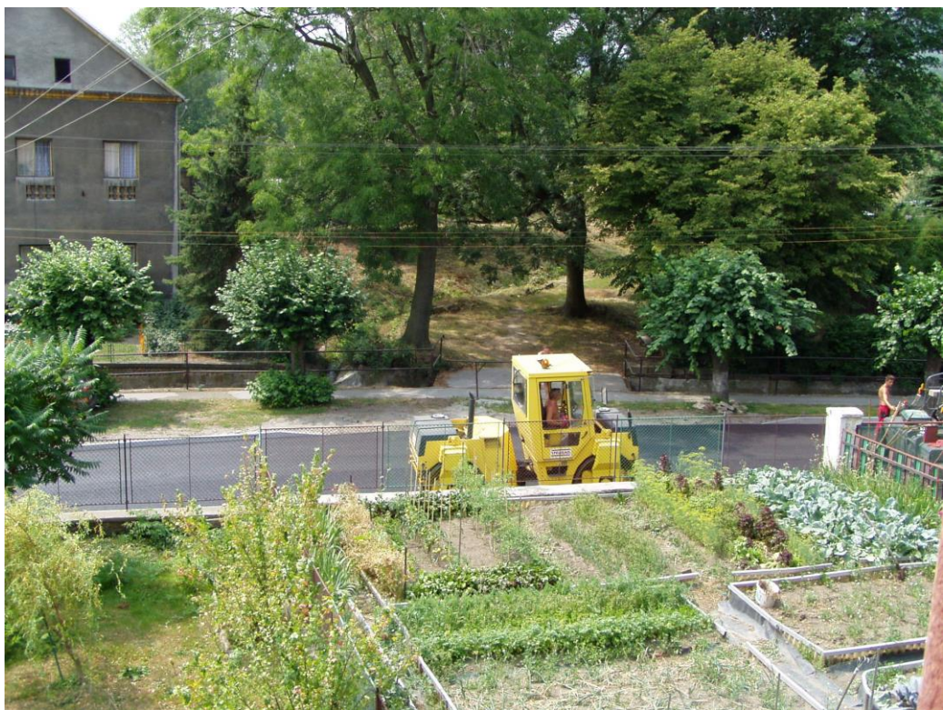
Kubátova silnice s novým AB (asfaltobetonovým) povrchem poslední úsek
