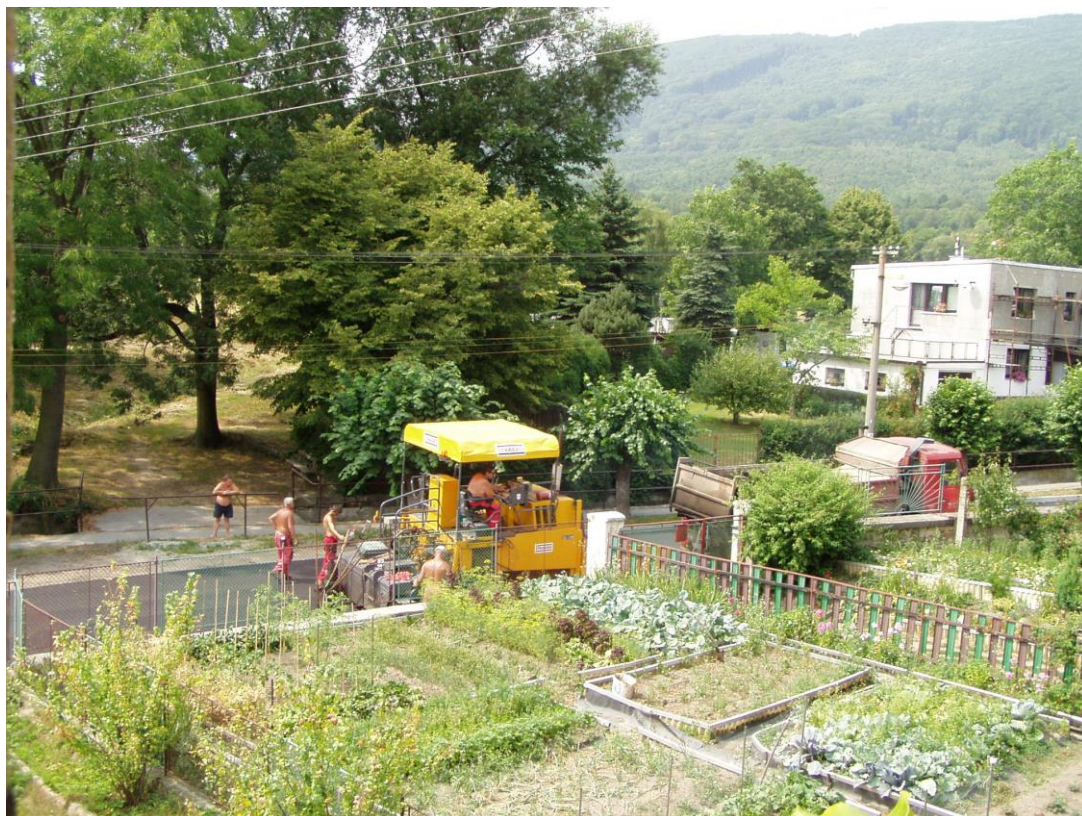
Poslední úsek nové pokládky asfaltu
