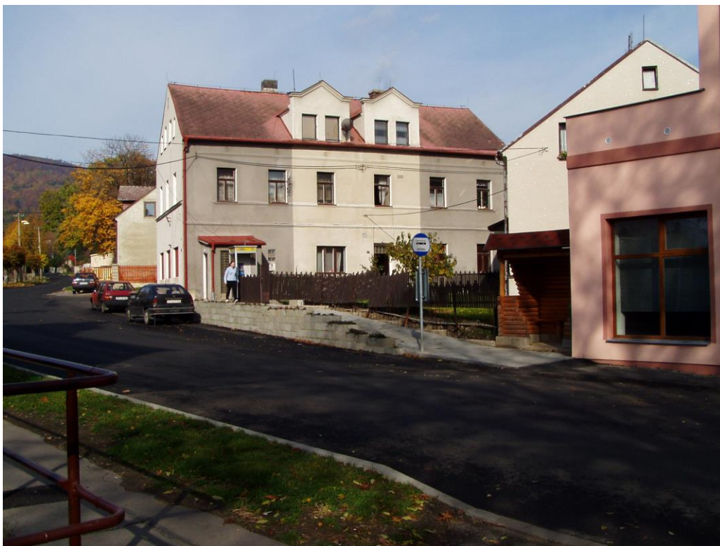
Úprava chodníku před poštou
