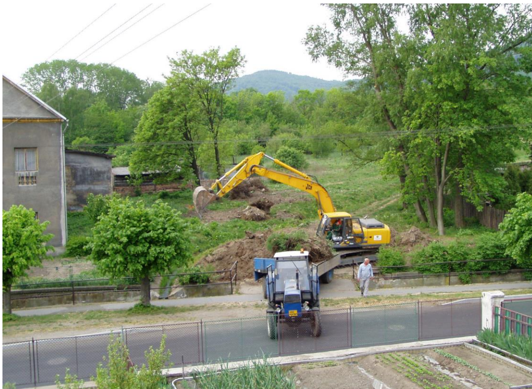
Likvidace pařezů pro stavbu silnice a inženýrských sítí nové zástavby rodinných domků
