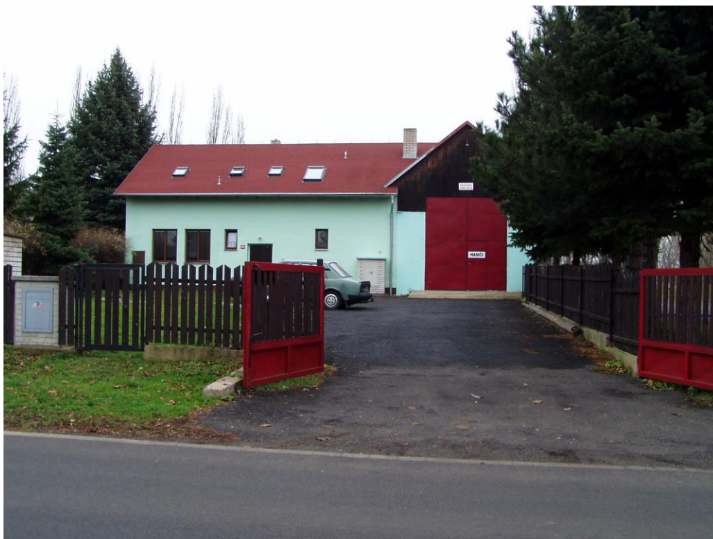
Výstavba tří podkrovních bytůvek v hasičské zbrojnici
