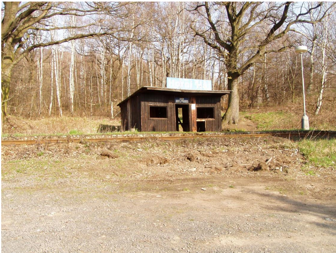
Železniční zastávka Horní Háj na trati Most – Moldava potřebuje nutnou opravu
