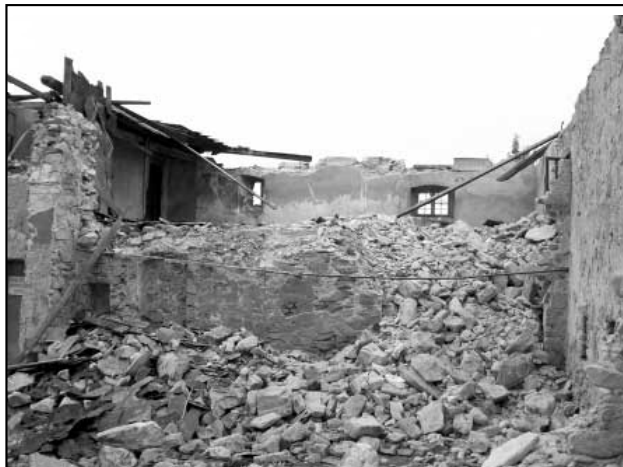
Demoliční práce probíhaly rychle
