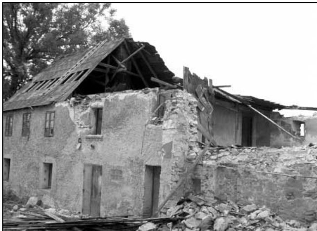
Demolice stodoly vedle OÚ
