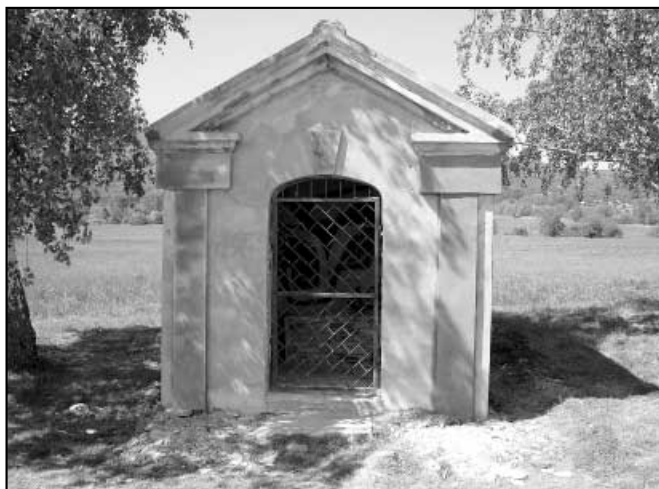
Kaplička během rekonstrukce.
