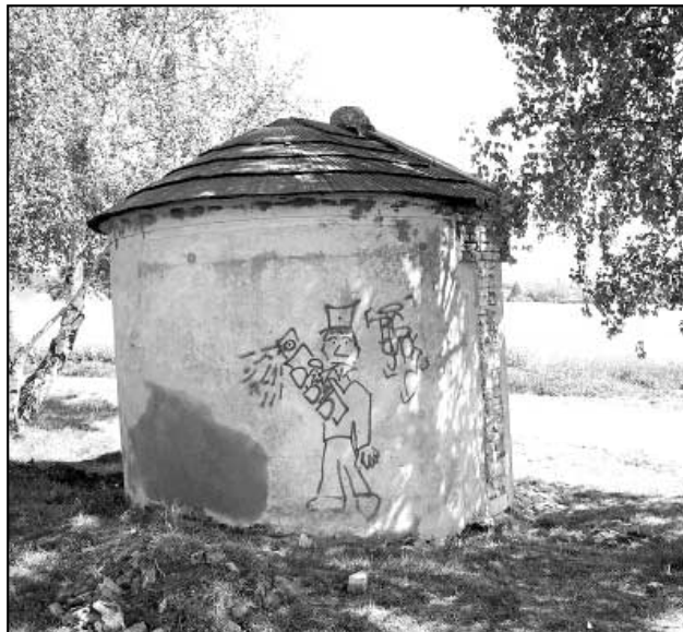
Hájská kaplička před rekonstrukcí.
