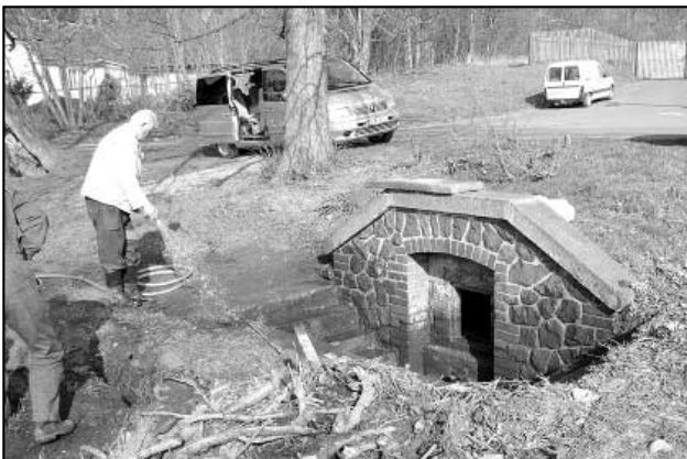
Obnova studnánky v Domaslavicích, kterou provedla údržba.
