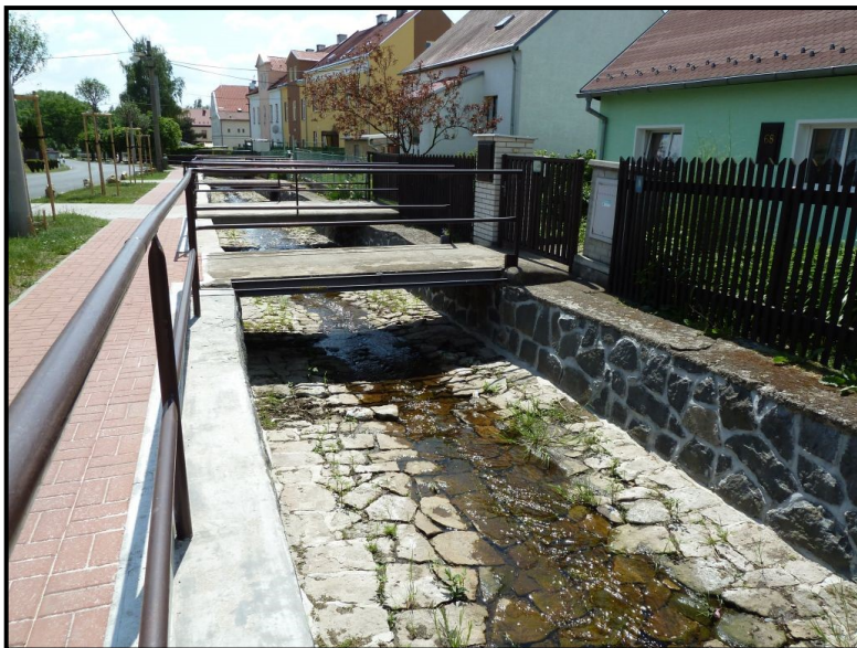
Foto č. 40: Hájský p. – Lávka a most k objektu č.p. 68 a most k č.p. 67 na ř. km 1,060, 1,054 a 1,038 v obci Háj u Duchcova
