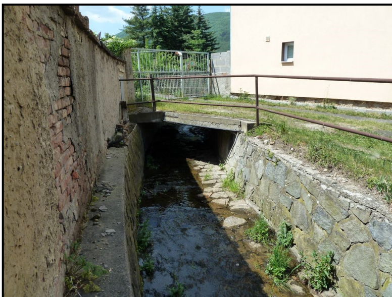
Foto č. 20: Hájský p. – Most k objektu č.p. 89 na ř. km 1,929 v obci Háj u Duchcova
