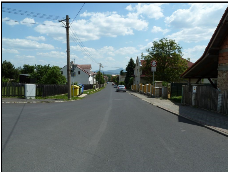
Foto č. 16: Hájský p. – Háj u Duchcova – komunikace v ul. Zelenkova na ř. km 2,85 - 2,58
