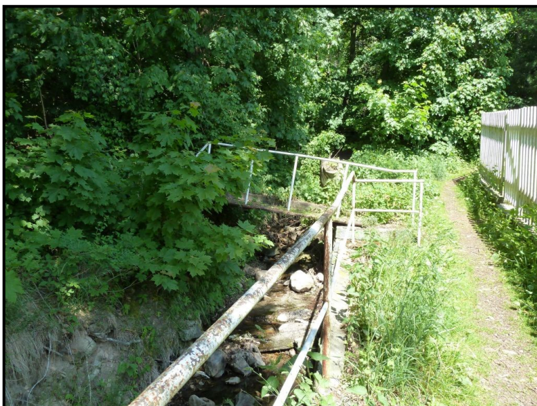
Foto č. 2: Hájský p. – Lávka u objektu č.p. 272 na ř. km 3,167 v obci Háj u Duchcova
