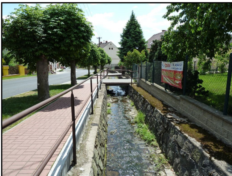
Foto č. 14: Hájský p. – Most k objektu č.p. 94 a 165 na ř. km 2,192 a 1,177 v obci Háj u Duchcova
