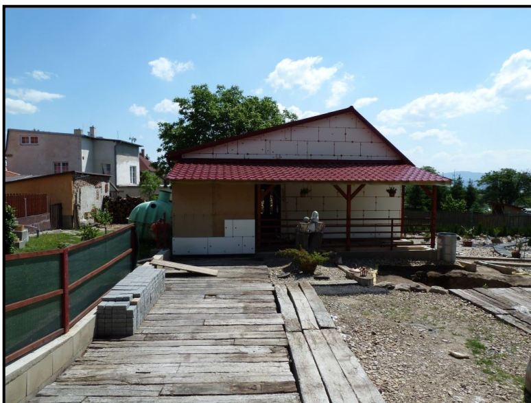
Foto č. 5:Hájský p. – Háj u Duchcova – objekt u č.p. 107 na LB na ř. km 2,80
