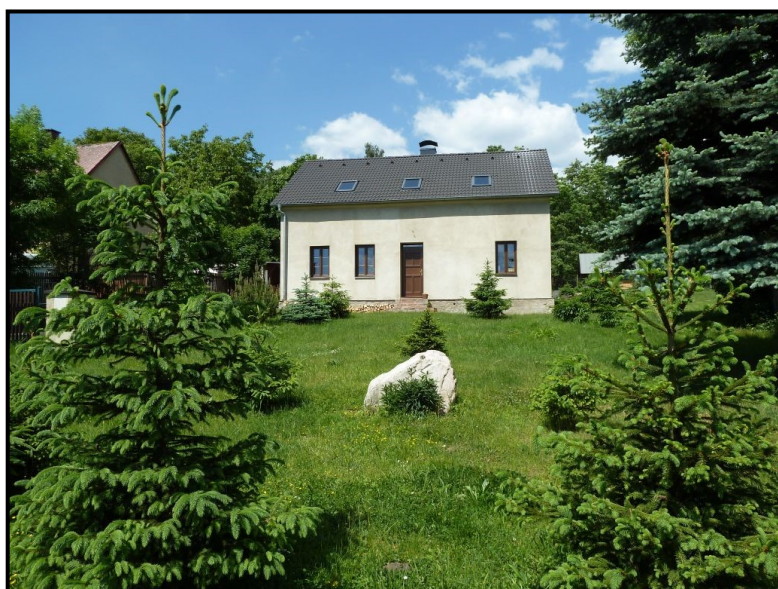
Foto č.2: Hájský p. – Háj u Duchcova – objekt č.p. 261 na PB na ř. km 2,89
