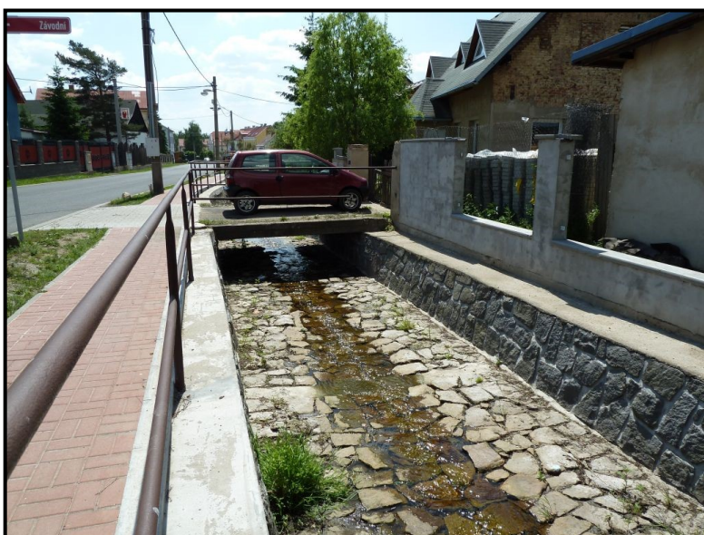
Foto č. 36: Hájský p. – Most k objektu č.p. 72 na ř. km 1,189 v obci Háj u Duchcova
