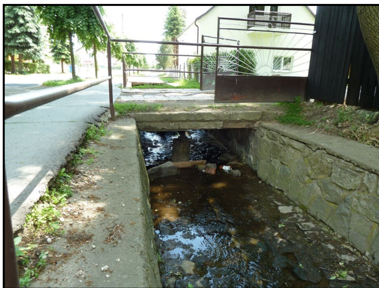
Foto č. 28: Hájský p. – Most nad objektem č.p. 81 na ř. km 1,659 v obci Háj u Duchcova
