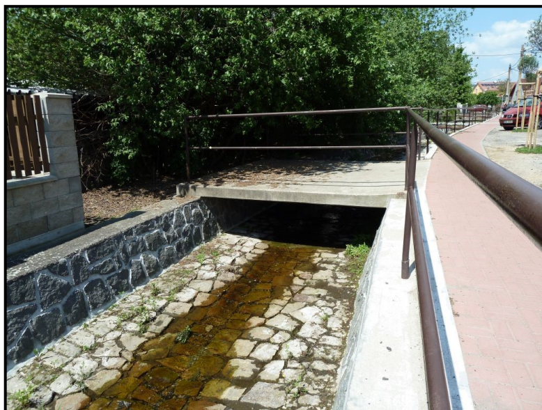
Foto č. 38: Hájský p. – Most pod objektem č.p. 70 na ř. km 1,115 v obci Háj u Duchcova
