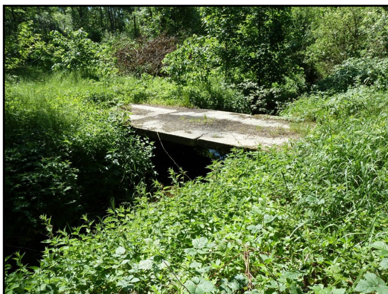
Foto č. 45: Hájský p. – Most u rybníka Salát na ř. km 0,325 v obci Háj u Duchcova
