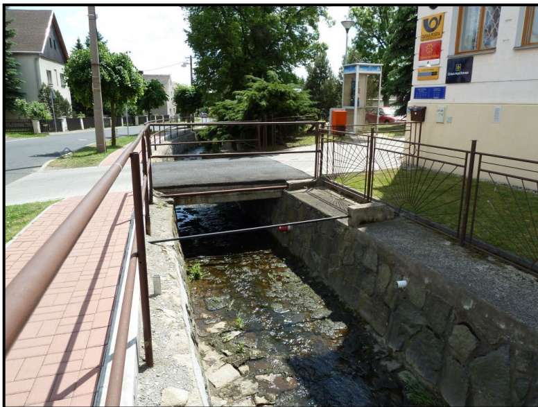
Foto č. 16: Hájský p. – Most k objektu OÚ č.p. 155 a pomocný hlásný profil na ř. km 2,107 v obci Háj u Duchcova
