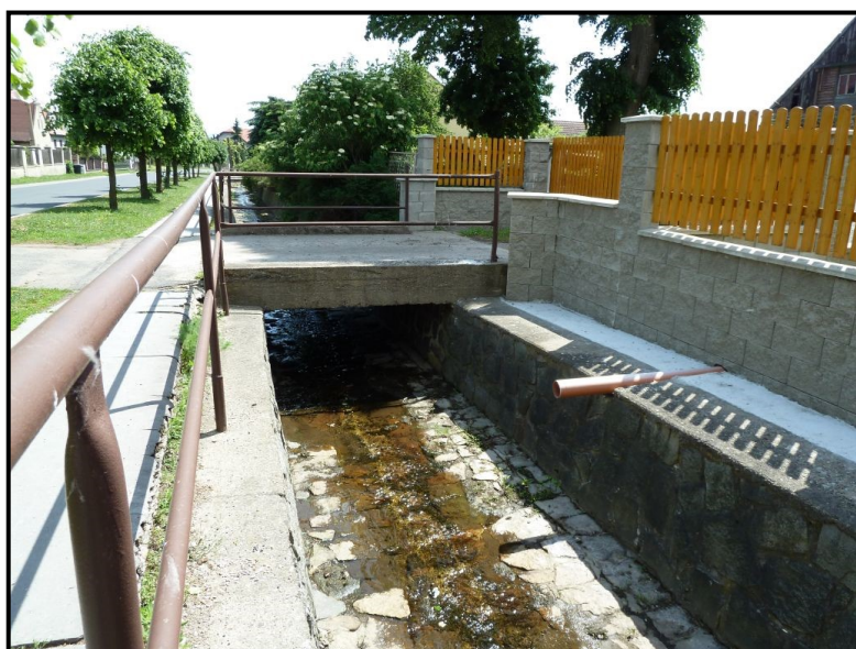
Foto č. 30: Hájský p. – Most k objektu č.p. 79 na ř. km 1,564 v obci Háj u Duchcova
