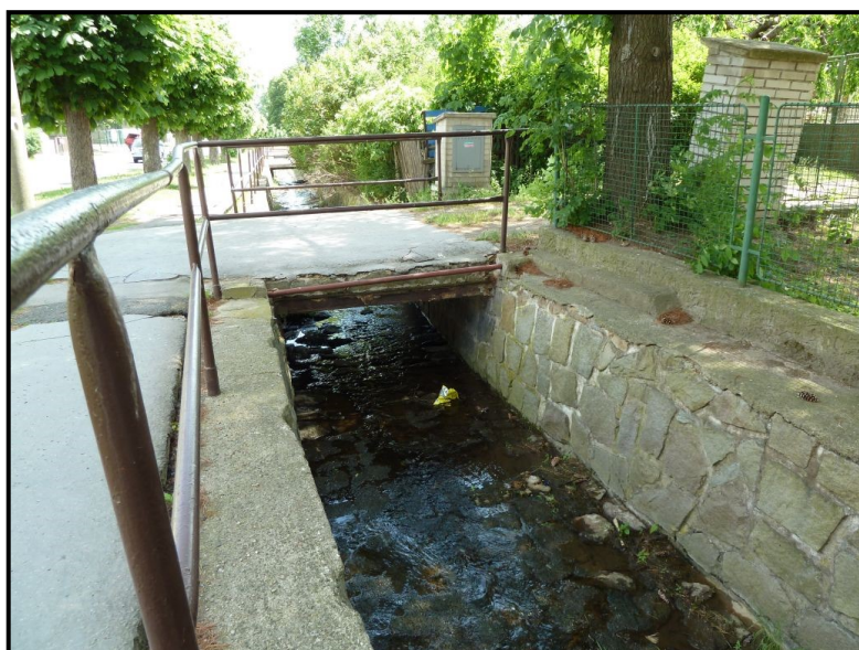
Foto č. 23: Hájský p. – Most k objektu č.p. 87 na ř. km 1,851 v obci Háj u Duchcova
