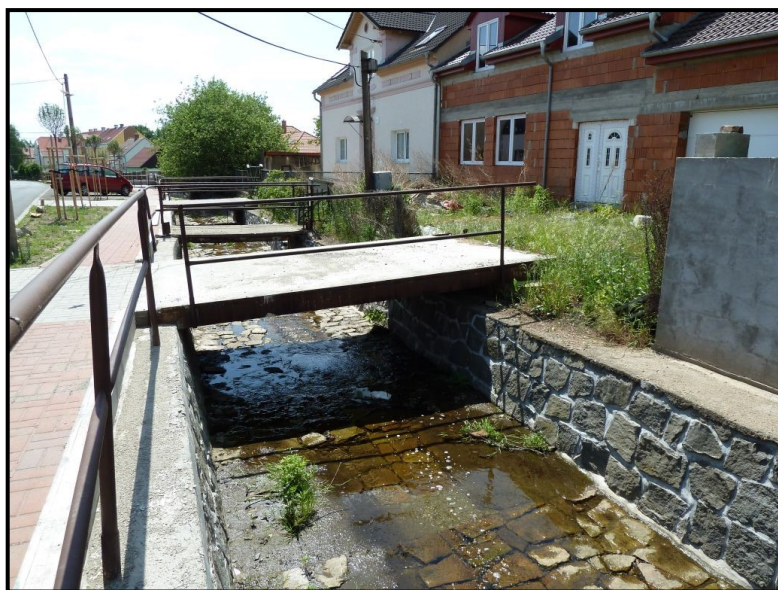
Foto č. 37: Hájský p. – 2 mosty k objektu č.p. 71 a most k č.p. 70 na ř. km 1,152 a 1,140 v obci Háj u Duchcova
