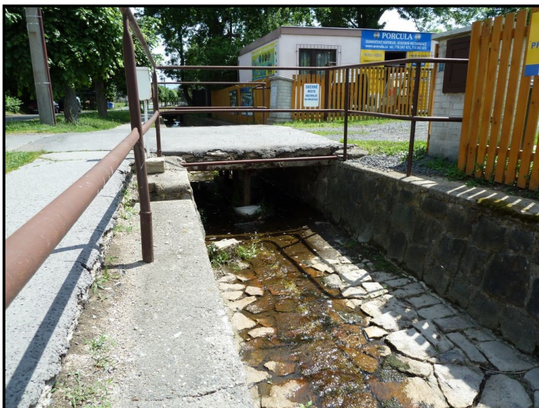
Foto č. 27: Hájský p. – Most k objektu č.p. 83 na ř. km 1,697 v obci Háj u Duchcova
