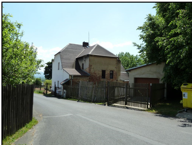
Foto č. 1:Hájský p. – Háj u Duchcova – objekt č.p. 191 na LB na ř. km 3,07
