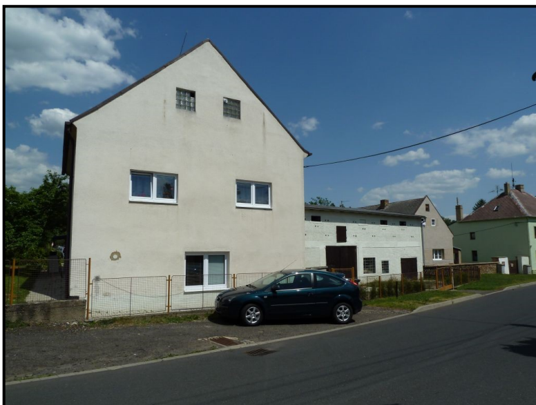
Foto č. 11: Hájský p. – Háj u Duchcova – objekt č.p. 36 na LB na ř. km 1,89
