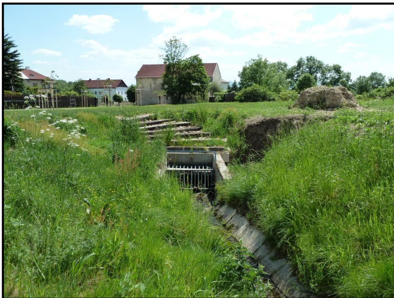
Foto č. 46: bezejmenný tok – Propustek v ul. Ke Knížáku na ř. km 0,090 v obci Háj u Duchcova
