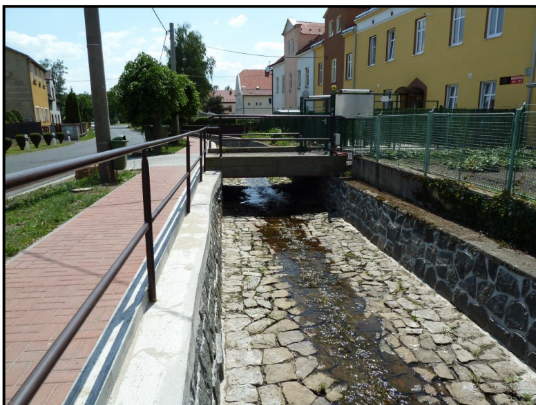
Foto č. 41: Hájský p. – Most u objektu č.p. 111 na ř. km 1,024 v obci Háj u Duchcova
