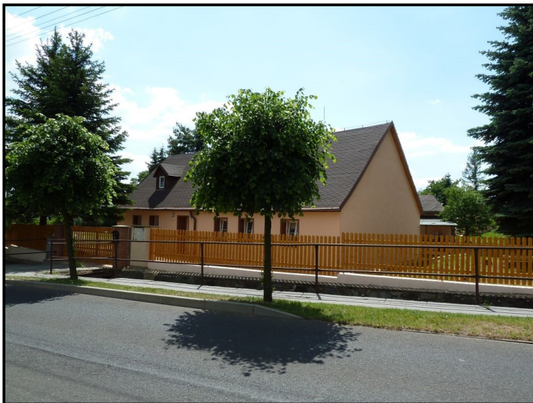
Foto č. 10: Hájský p. – Háj u Duchcova – objekt č.p. 90 na PB na ř. km 2,00
