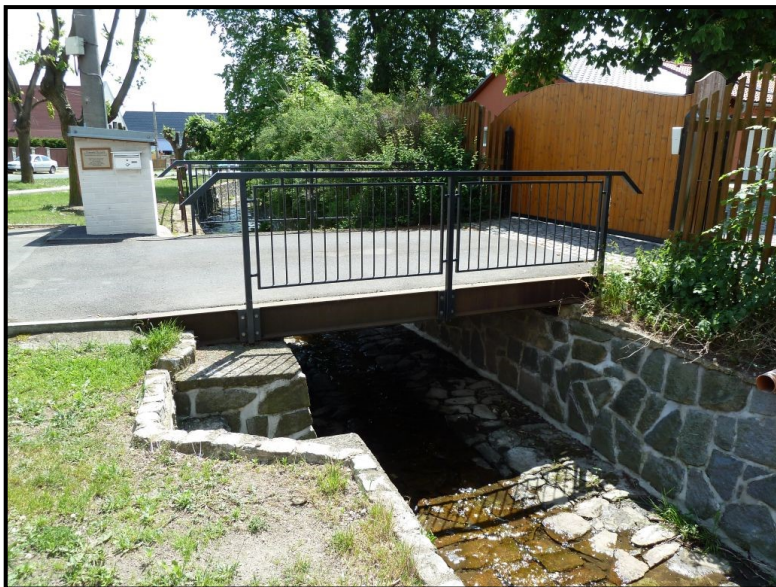
Foto č. 34: Hájský p. – Most k objektu č.p. 74 na ř. km 1,304 v obci Háj u Duchcova
