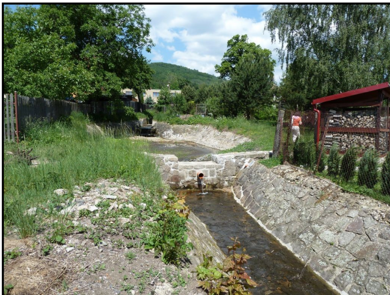
Foto č. 7: Hájský p. – Přehrážka pod objektem č.p. 230 na ř. km 2,786 v obci Háj u Duchcova
