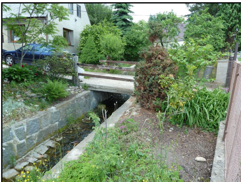
Foto č. 8: Hájský p. – Lávka k objektu č.p. 98 na ř. km 2,393 v obci Háj u Duchcova
