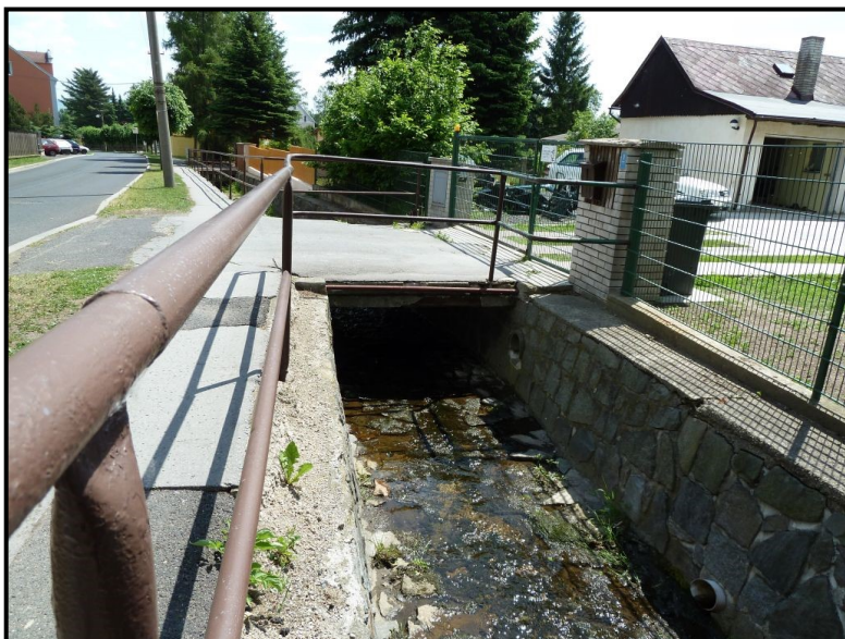
Foto č. 18: Hájský p. – Most k objektu č.p. 91 na ř. km 2,023 v obci Háj u Duchcova
