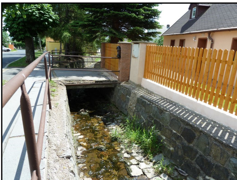
Foto č. 19: Hájský p. – Most k objektu č.p. 90 na ř. km 1,988 v obci Háj u Duchcova
