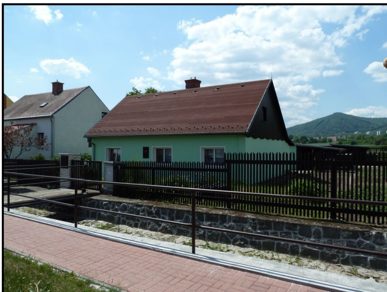
Foto č. 12: Hájský p. – Háj u Duchcova – objekt č.p. 68 na PB na ř. km 1,07
