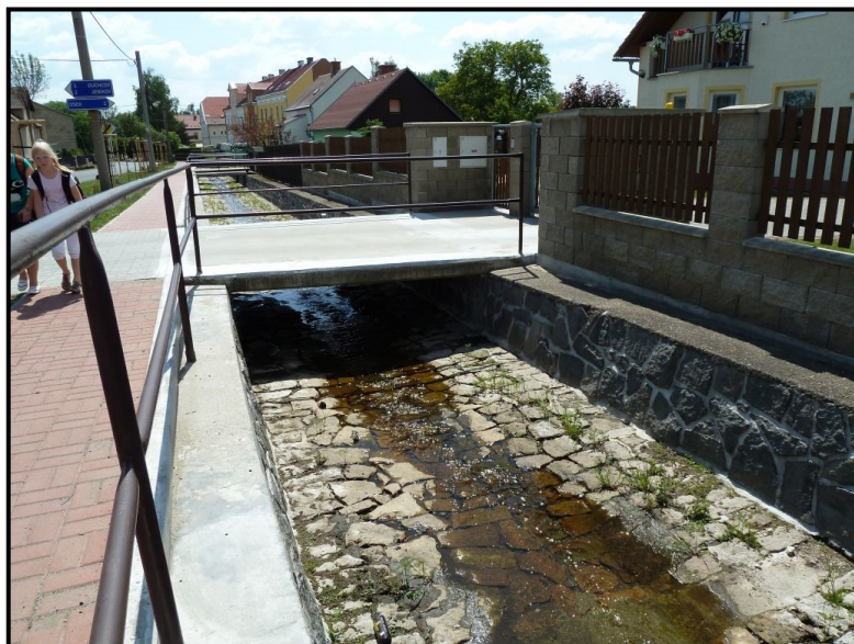
Foto č. 39: Hájský p. – Most k objektu č.p. 280 na ř. km 1,097 v obci Háj u Duchcova
