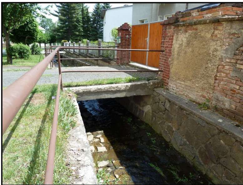
Foto č. 21: Hájský p. – Most k objektu č.p. 135 na ř. km 1,914 v obci Háj u Duchcova
