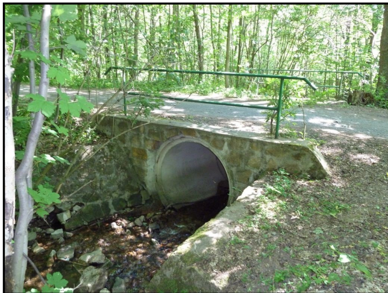
Foto č. 49: Domaslavický p. – Propustek nad koupalištěm na ř. km 0,680 v obci Domaslavice
