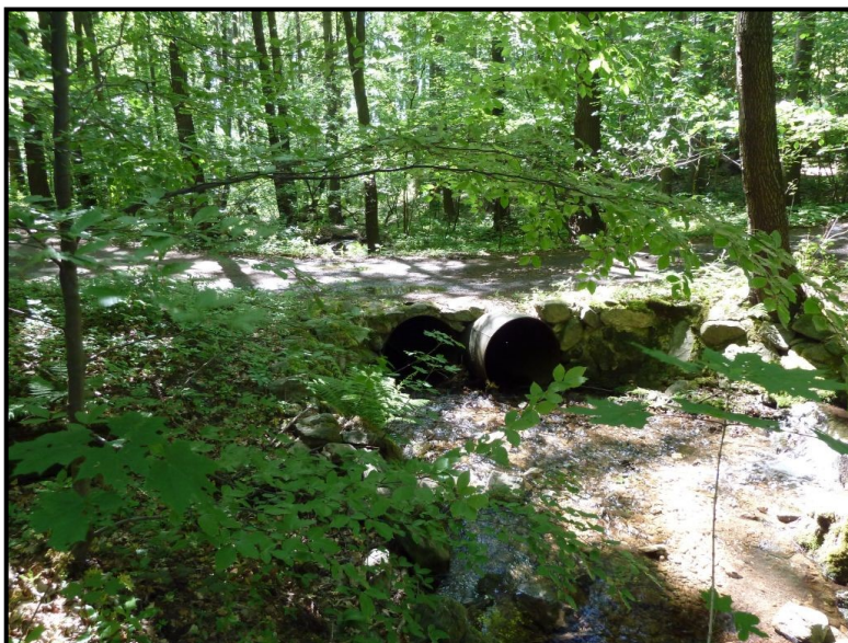
Foto č. 48: Domaslavický p. – Propustek u sádek na ř. km 0,950 v obci Domaslavice
