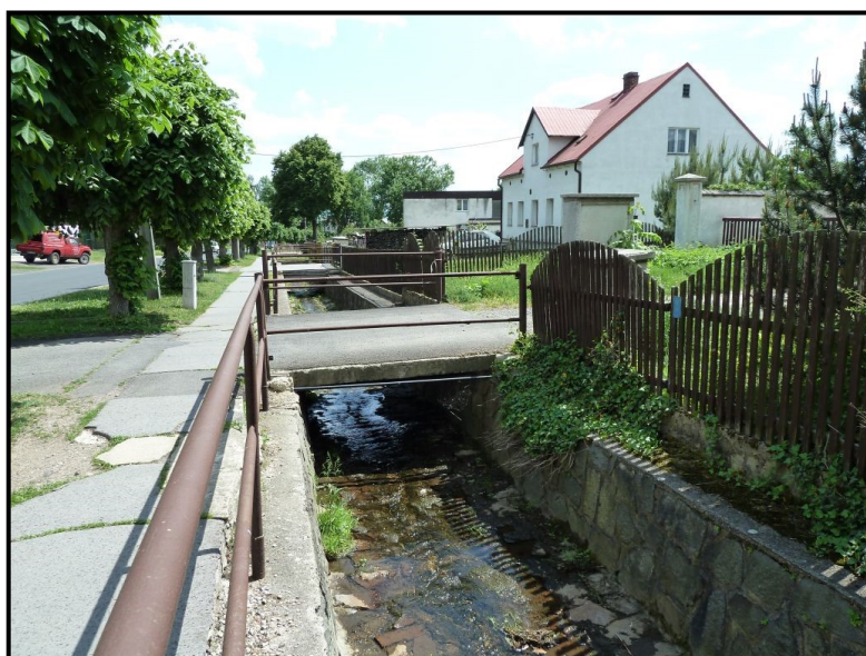
Foto č. 24: Hájský p. – Most k objektu č.p. 271 na ř. km 1,819 v obci Háj u Duchcova
