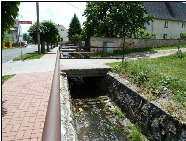
Foto č. 13: Hájský p. – Most na křižovatce ul. Ke Kapličce a Kubátova na ř. km 2,212 v obci Háj u Duchcova
