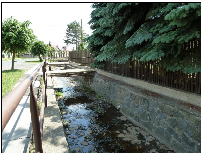
Foto č. 31: Hájský p. – Most k objektu č.p. 78, č.e. 1 a č.p. 147 na ř. km 1,500, 1,483 a 1,463 v obci Háj u Duchcova
