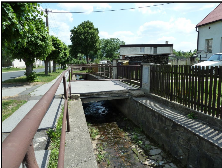
Foto č. 25: Hájský p. – 2 mosty u objektu č.p. 86 na ř. km 1,795 a 1,776 v obci Háj u Duchcova
