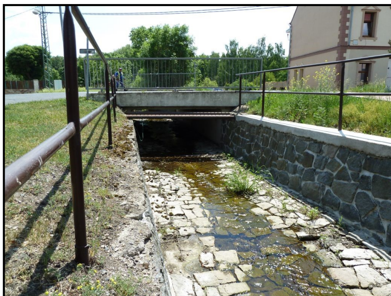
Foto č. 43: Hájský p. – Silniční most v Osecké ul. na ř. km 0,884 v obci Háj u Duchcova
