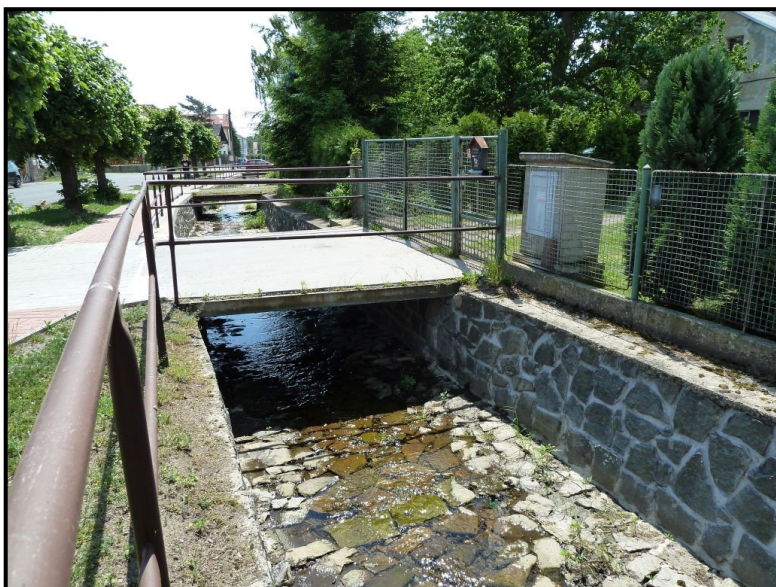
Foto č. 35: Hájský p. – Most k objektu č.p. 221 a 73 na ř. km 1,250 a 1,230 v obci Háj u Duchcova
