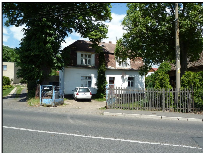
Foto č. 3:Hájský p. – Háj u Duchcova – objekt č.p. 5 na LB na ř. km 2,86
