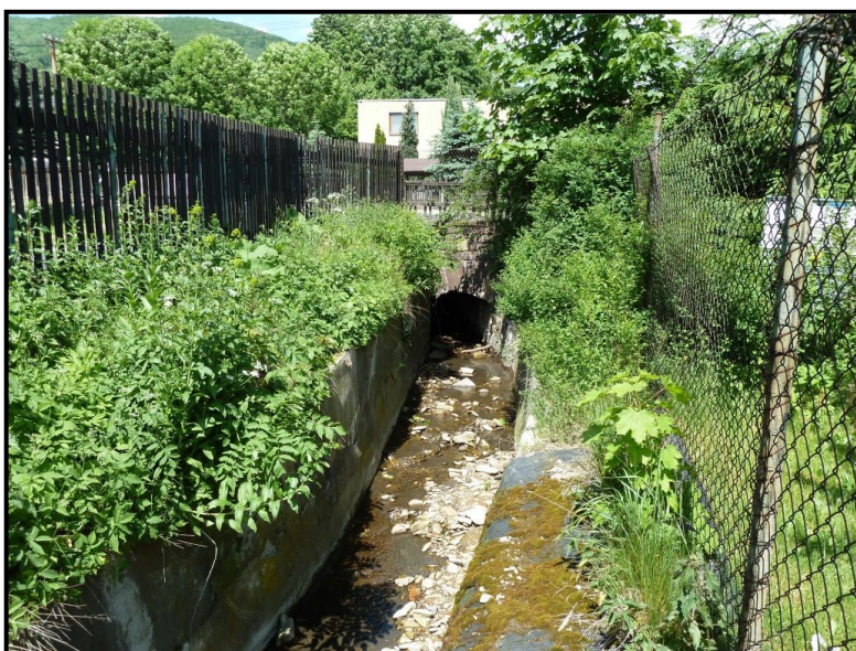
Foto č. 6: Hájský p. – Most na silnici č. I/27 na ř. km 2,849 v obci Háj u Duchcova
