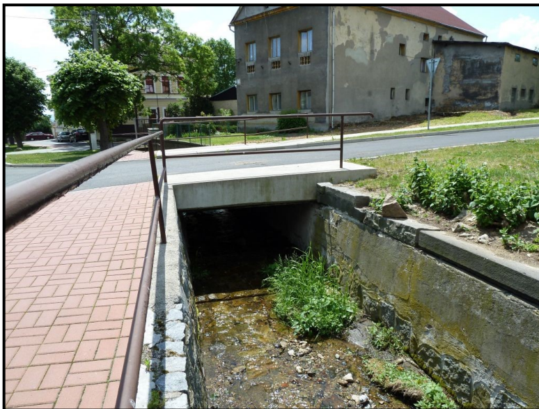
Foto č. 10: Hájský p. – Most na křižovatce ul. Ke Knížáku a Kubátova na ř. km 2,333 v obci Háj u Duchcova
