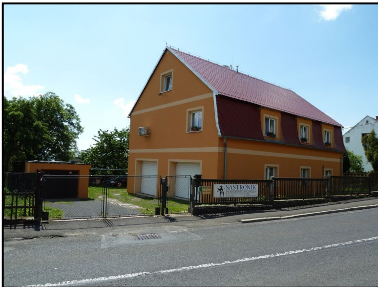
Foto č. 4:Hájský p. – Háj u Duchcova – objekt č.p. 230 na PB na ř. km 2,84
