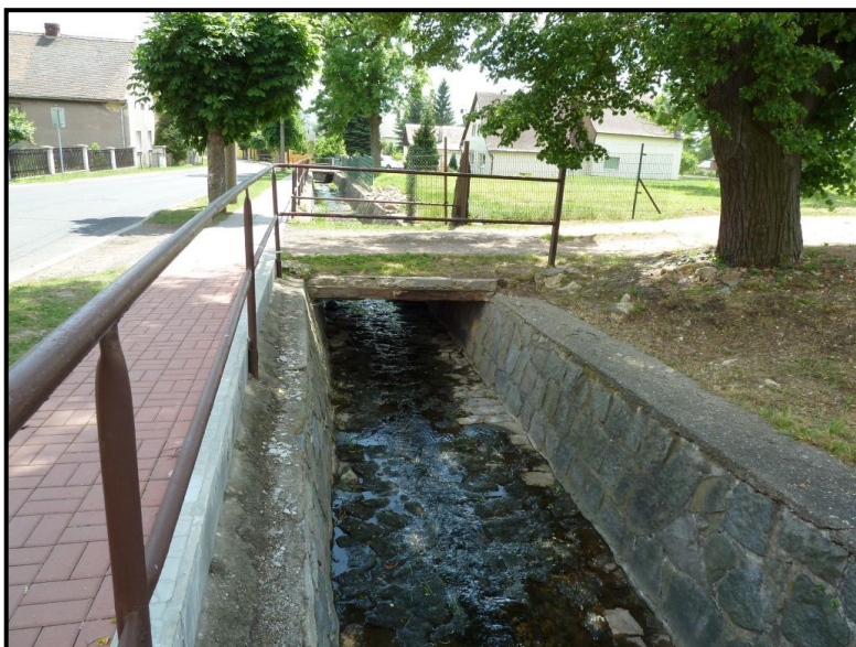
Foto č. 17: Hájský p. – Most pod objektem č.p. 155 na ř. km 2,079 v obci Háj u Duchcova
