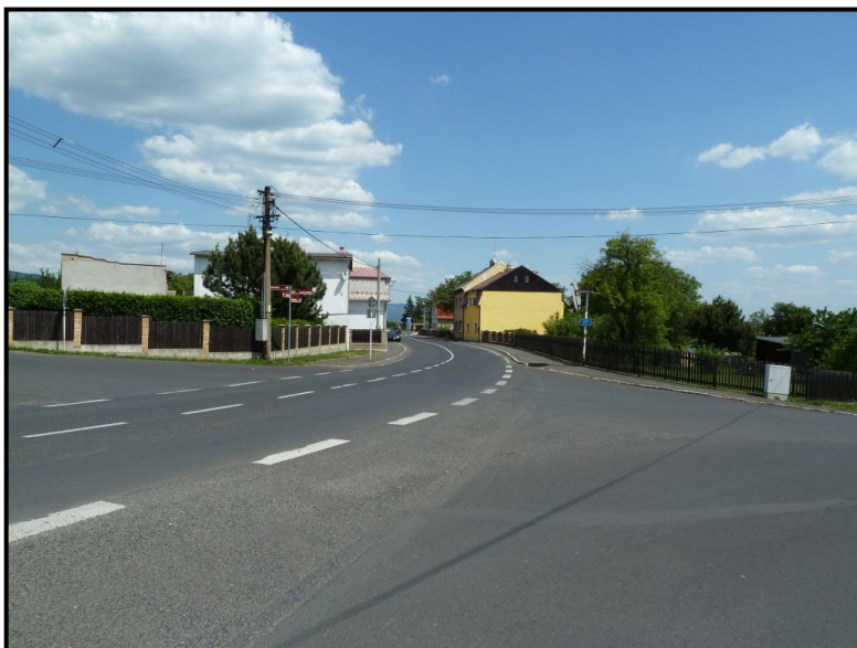
Foto č. 15: Hájský p. – Háj u Duchcova – komunikace v ul. Hanzlíčkova na ř. km 2,84
