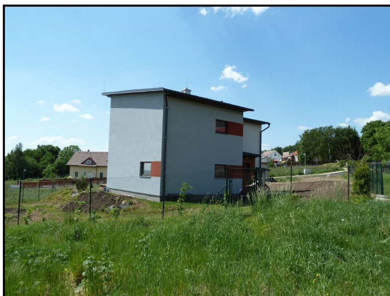
Foto č.8: Hájský p. – Háj u Duchcova – objekt č.p. 298 na PB na ř. km 2,78
