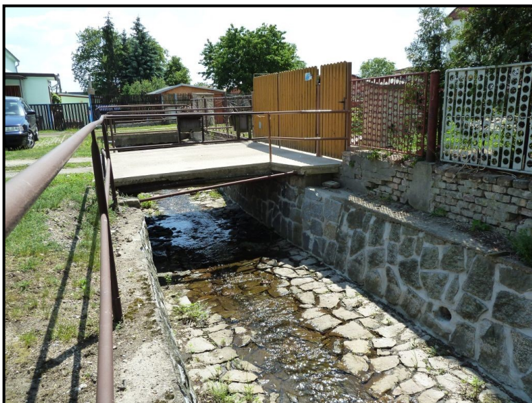
Foto č. 33: Hájský p. – Most k objektu č.p. 154 a 75 na ř. km 1,363 a 1,352 v obci Háj u Duchcova
