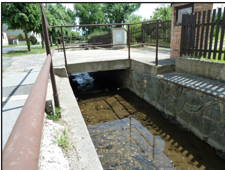
Foto č. 26: Hájský p. – Most k objektu č.p. 84 na ř. km 1,743 v obci Háj u Duchcova
