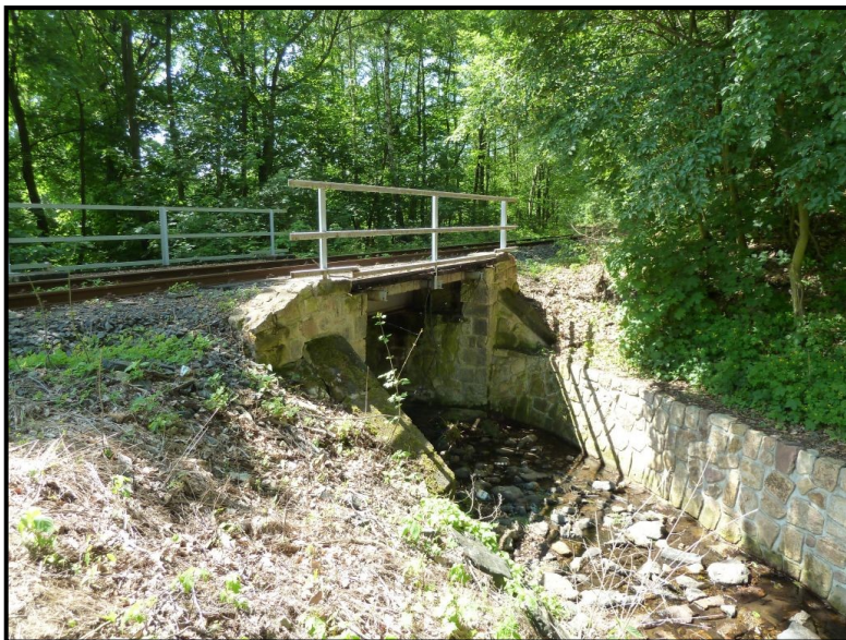
Foto č. 1: Hájský p. – Žel. most u zastávky Háj u Duchcova na ř. km 3,197 v obci Háj u Duchcova
