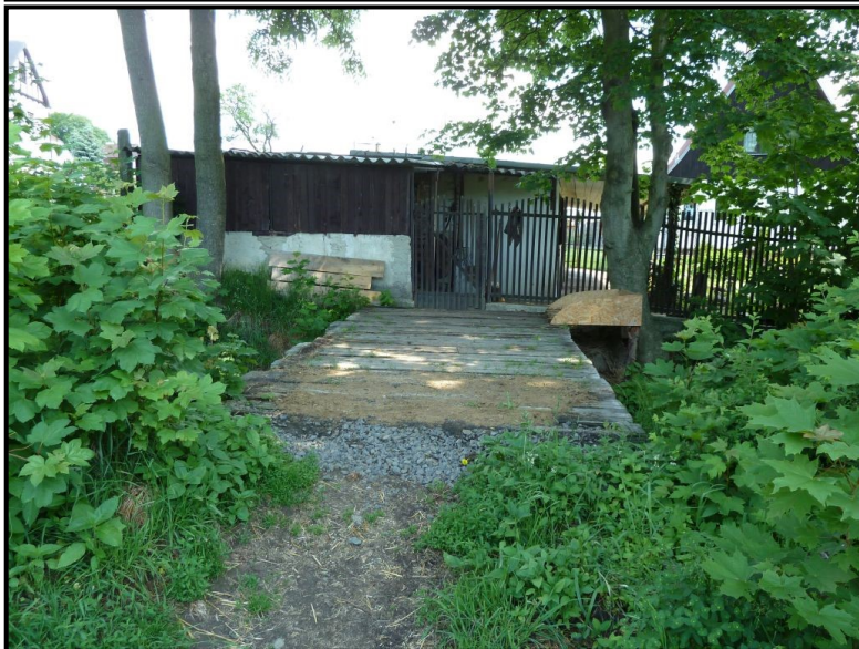
Foto č. 5: Hájský p. – Lávka u objektu č.p. 263 na ř. km 3,022 v obci Háj u Duchcova
