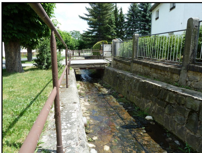
Foto č. 22: Hájský p. – Most k objektu č.p. 88 na ř. km 1,889 v obci Háj u Duchcova
