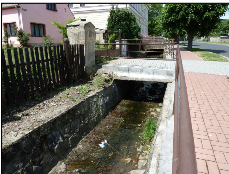
Foto č. 12: Hájský p. – Most k objektu č.p. 95 na ř. km 2,241 v obci Háj u Duchcova
