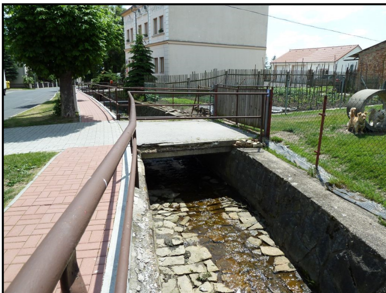
Foto č. 15: Hájský p. – Most nad objektem č.p. 155 na ř. km 2,141 v obci Háj u Duchcova
