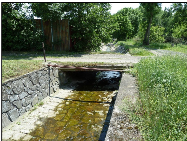
Foto č. 44: Hájský p. – Most u objektu č.p. 63 na ř. km 1,097 v obci Háj u Duchcova
