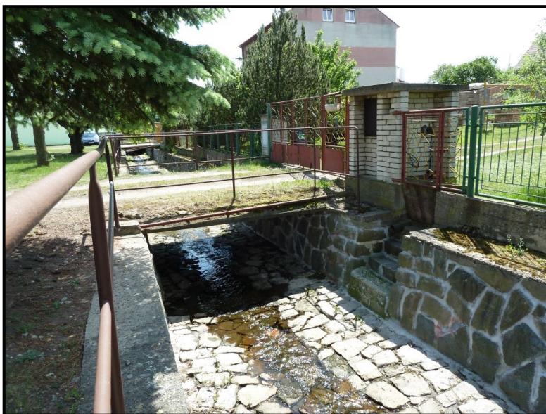
Foto č. 32: Hájský p. – Most k objektu č.p. 76 na ř. km 1,399 v obci Háj u Duchcova
